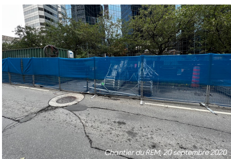
Chantier du REM, 20 septembre 2020
