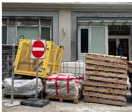
Chantier du REM, 20 septembre 2020
