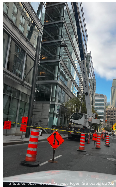
Situation observée sur l'avenue Viger, le 8 octobre 2022
