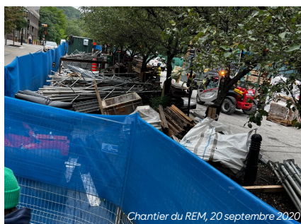
Chantier du REM, 20 septembre 2020
