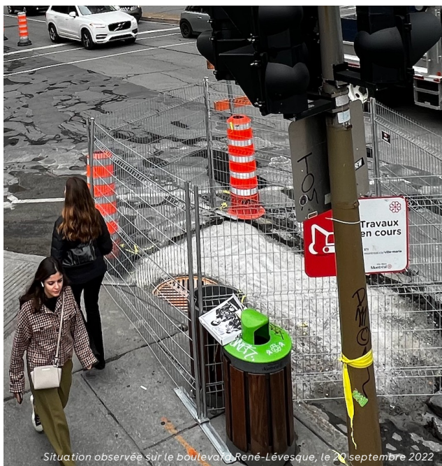
Situation observée sur le boulevard René-Lévesque, le 20 septembre 2022
