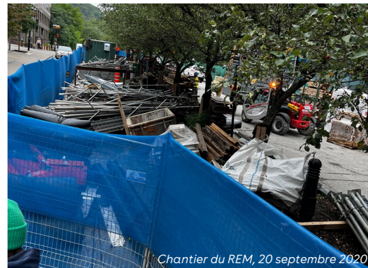
Chantier du REM, 20 septembre 2020
