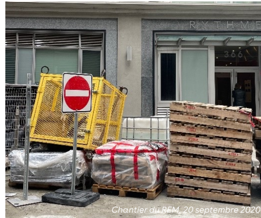
Chantier du REM, 20 septembre 2020
