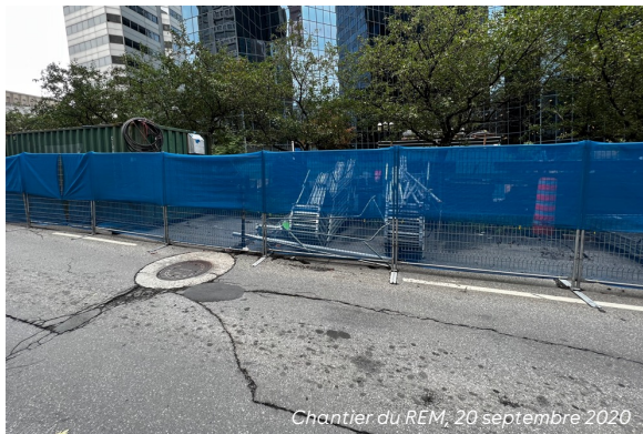
Chantier du REM, 20 septembre 2020
